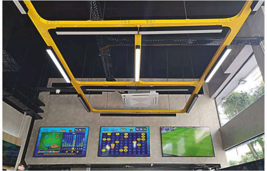
ΚΩΔ.209-22 Ειδικές κατασκευές οροφής - RAFT
